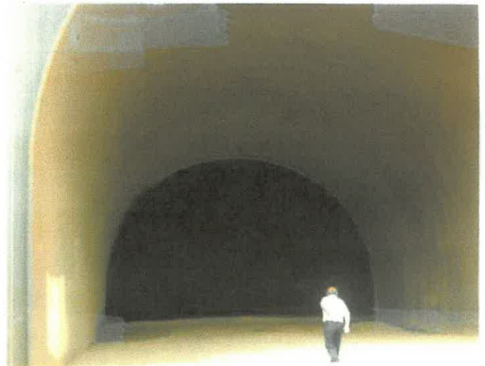
爆着作業用ドーム
